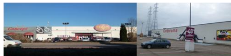
Le Coteau / Mably – Des boîtes à chaussures vieillissantes
