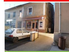
Roanne / La Pacaudière - Accessibilité PMR (rampes, revêtement)
